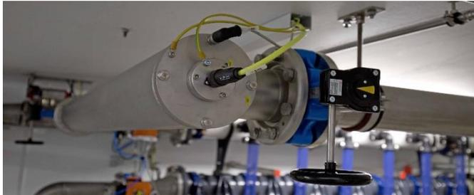
Da die Desinfektion mittels UV-Bestrahlung aber keine Depotwirkung im Trinkwasser erzeugt, kommt sie nur dort zum Einsatz, wo das Trinkwasser hygienisch einwandfreie nachgeschaltete Versorgungsanlagen (intakte Rohrleitungen und Behälter) durchläuft.
