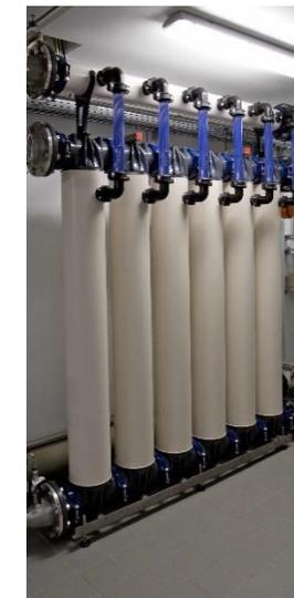
Da mögliche mikrobiologische Belastungen (z.B. Bakterien, Parasiten und Viren) größer als die Porenweite der Membranen sind, werden diese genauso wie feinere Trübungen vollständig zurückgehalten. Man spricht bei der Ultrafiltrationstechnik daher auch von einer „mechanischen Desinfektion“ des Wassers.
