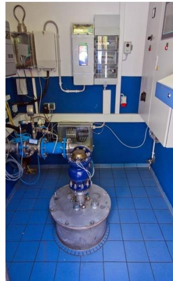
Aus dem Brunnen (Durchmesser: 200 mm; Tiefe: ca. 50 m) fördert die UWMP aus etwa 43 m Tiefe über eine Steigleitung DN 65 das Rohwasser durch Aufbereitungsstufen des Wasserwerkes in den Hochbehälter. Das Rohwasser, das bereits von vergleichsweise guter Qualität ist, ist calcitlösend und weist nur zeitweise Trübungen (sehr kleine Partikel) sowie mikrobiologische Belastungen (z.B. Bakterien, Keime) auf.
