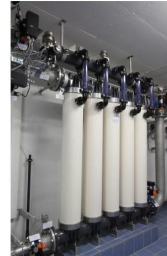
sind, werden diese genauso wie feinere Trübungen vollständig zurückgehalten. Man spricht bei der Ultrafiltrationstechnik daher auch von einer „mechanischen Desinfektion“ des Wassers.
