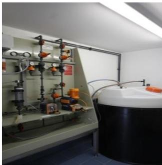
Im Zulauf zum Hochbehälter (= Trinkwasserspeicher) wird dem weichen, gering kalkaggressiven Rohwasser zur Einstellung des „Kalk-Kohlensäure-Gleichgewichts“ Natronlauge (NaOH) zudosiert.
