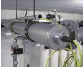
Da die Desinfektion mittels UV-Bestrahlung aber keine Depotwirkung im Trinkwasser erzeugt, kommt sie nur dort zum Einsatz, wo das Trinkwasser hygienisch einwandfreie nach-geschaltete Versorgungsanlagen (intakte Rohrleitungen und Behälter) durchläuft.
