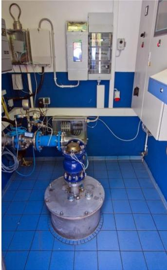
Das Wasserwerk Dörnholthausen ging im April 2012 offiziell in Betrieb. Die Aufbereitungstechnik wurde in die Vorkammer des ebenfalls neu errichteten Hochbehälters Dörnholthausen integriert, wodurch Gebäudekosten eingespart werden konnten. Die Baukosten betragen knapp 270.000 €.
