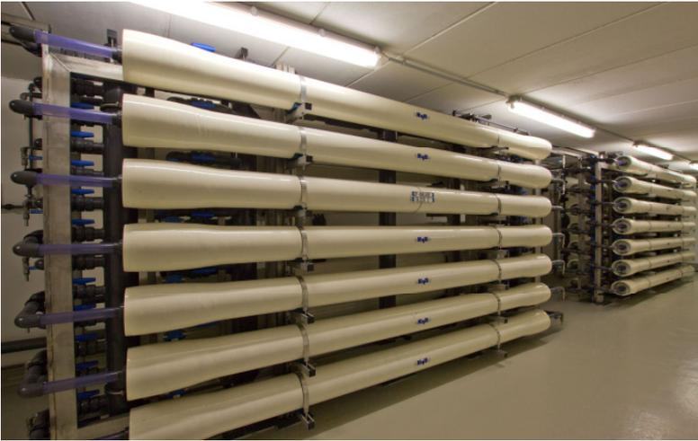
Durch diese hochmoderne Filtrationstechnik werden sämtliche Partikel bis zu einer Größe von  $0,01 \mu\text{m}$  sicher herausgefiltert. Da mögliche mikrobiologische Belastungen (z.B. Bakterien, Parasiten und Viren) größer als die Porenweite der Membranen sind, werden auch diese neben den feineren Trübungen vollständig zurückgehalten. Man spricht bei der Ultrafiltrationstechnik auch von einer „mechanischen Desinfektion“ des Wassers.
