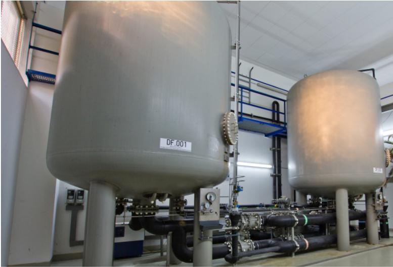
In zwei parallel betriebenen Mehrschichtfiltern aus Steinkohlenkoks und Filtersand findet eine Vorfiltration zur Entfernung von größeren Trübstoffen statt. Gleichzeitig wird über Bakterien nur in Spuren vorhandenes Mangan entfernt („biologische Entmanganung“). (Filterhöhe: 4 m; Schütthöhe: 2,8 m; Durchmesser: 3 m)
