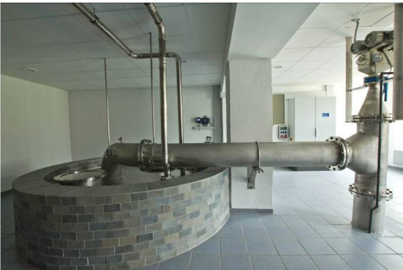
Die im Wasserrecht genehmigten Entnahmemengen für die Wassergewinnungsanlage „Schachtbrunnen Röhre“ belaufen sich auf 250 m<sup>3</sup>/h, 4.500 m<sup>3</sup>/d und 1,2 Mio. m<sup>3</sup>/a. Aus diesem im Jahr 2009 komplett sanierten Schachtbrunnen (Durchmesser: 2,50 m; Tiefe: 6,30 m) entnehmen Pumpen über eine Saugleitung das Rohwasser und fördern dieses durch die nachfolgend beschriebenen Aufbereitungsstufen des Wasserwerks.
