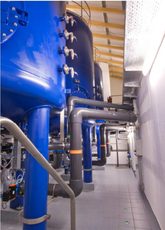
Diese Aufbereitungsstufe dient der Elimination von chlorierten Kohlenwasserstoffen (CKW), die in Spuren ( $< 2 \mu\text{g/l}$ ) hin und wieder im Rohwasser zu finden sind, und von sonstigen gelösten organischen Störstoffen. Zudem werden aber auch gröbere Trübstoffe zurückgehalten, die nach besonderen Regenereignissen im Rohwasser enthalten sein können. Jeder der drei Druckfilter ist mit etwa  $20 \text{ m}^3$  Aktivkohle gefüllt (Filterhöhe: 8 m; Schütthöhe: 2,70 m; Durchmesser: 3 m).
