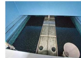
Filterfläche: 10,6 m<sup>2</sup>; Schütthöhe: 3,3 m; Inhalt: 35 m<sup>3</sup> je Filter
