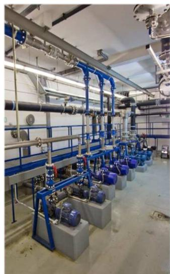
Im Ablauf der Trinkwasserpumpen erfolgt eine chemische Desinfektion durch Zugabe der gesetzlich vorgeschriebenen Mindestmenge von 0,05 mg/l Chlordioxid. Da am Ablauf der Ultrafiltrationsanlage stets Trinkwasserqualität vorlag, hat diese Desinfektion im Wasserwerk Langscheid die Bedeutung einer „Sicherheitsdesinfektion“.
