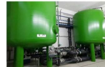
Filterhöhe: 4 m; Durchmesser: 3 m; Schütthöhe: 2,8 m
